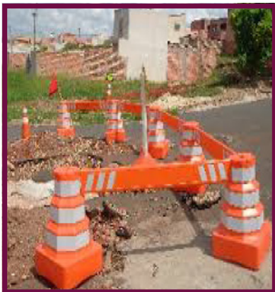
Isolamento da área
